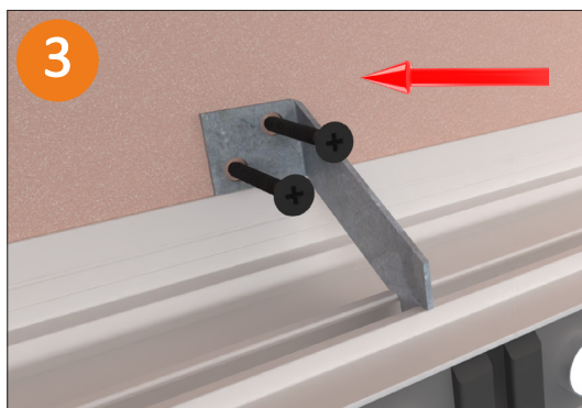
„Aussteifungswinkel / Bohrlöcher anzeichnen, vorbohren und festschrauben“
